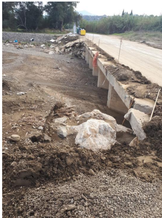
Acceso, puente sobre Río Seco
